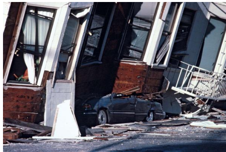
Фиг. 8. Ефект от втечняване на почвата
